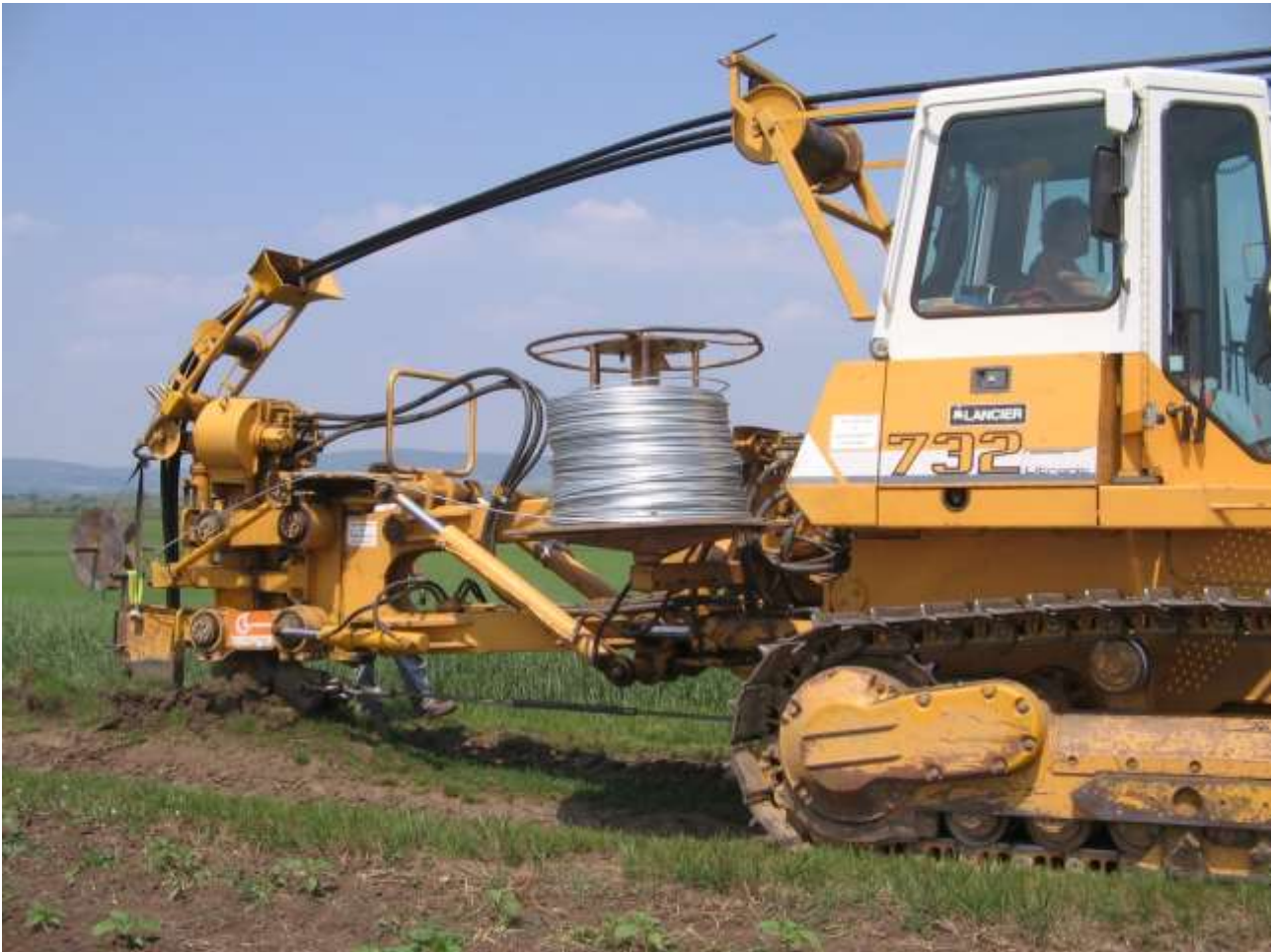
Abb. 2: Pflügearbeiten für die Erdverkabelung (Foto: S. Raab) - transferring medium voltage power lines below the soil.
