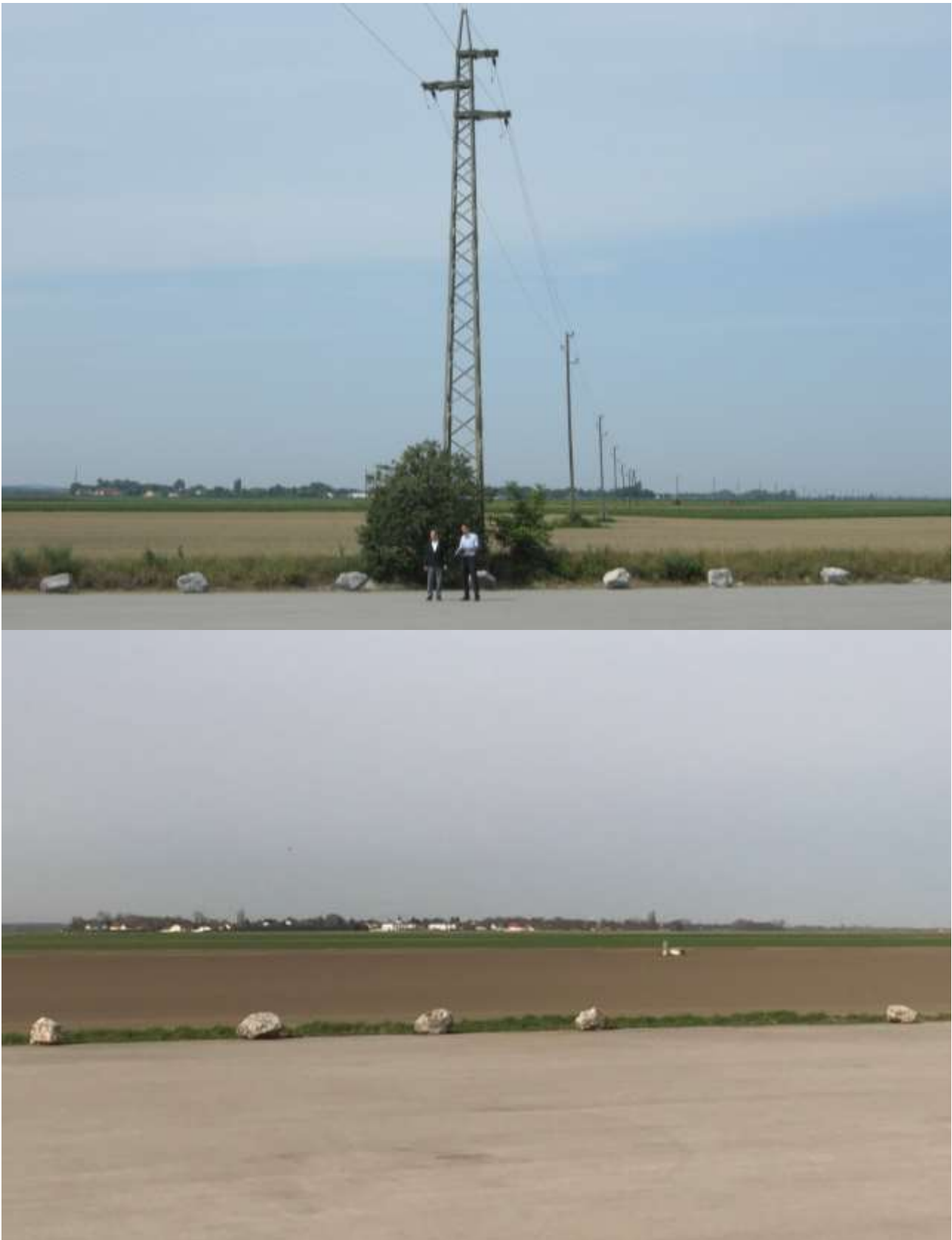
Abb. 1: Mittelspannungsleitungen im Trappengebiet Sandboden und Praterterrasse nahe Kopfstetten (am 24.07.2012 – Foto oben), die im Rahmen des Projekts abgebaut wurden (am 12.04.2018 – Foto unten; Fotos: R. Raab) - medium voltage power lines that were transferred below the soil.
