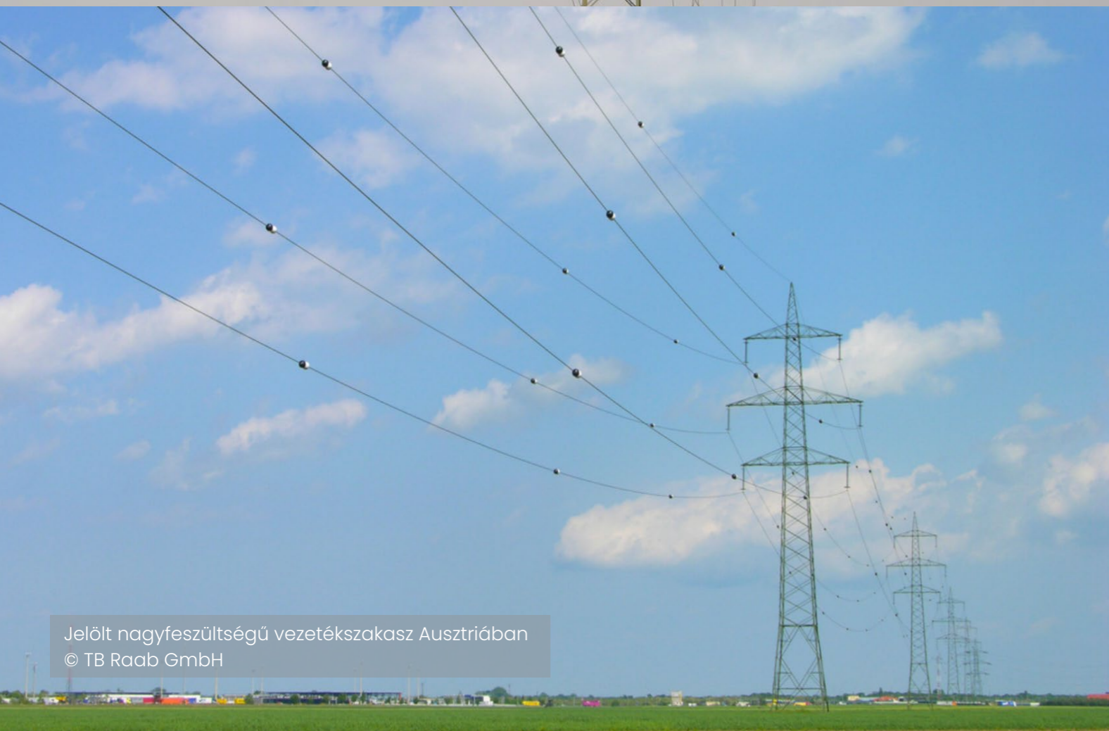
Nagyfeszültségű vezetékszakaszok jelölése Ausztriában © TB Raab GmbH
